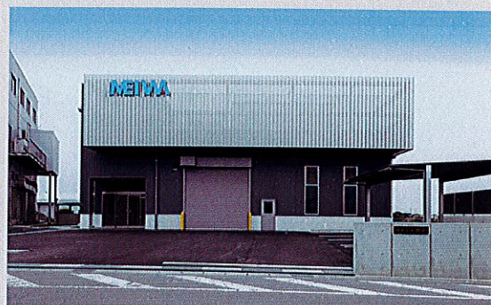
東端第二工場
